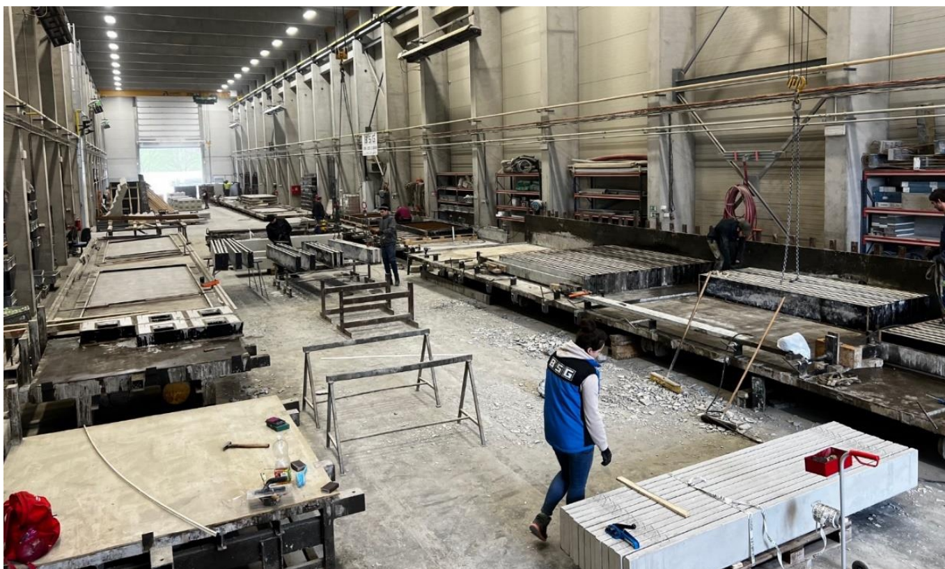
Nová výrobní hala prefabrikovaných prvků
